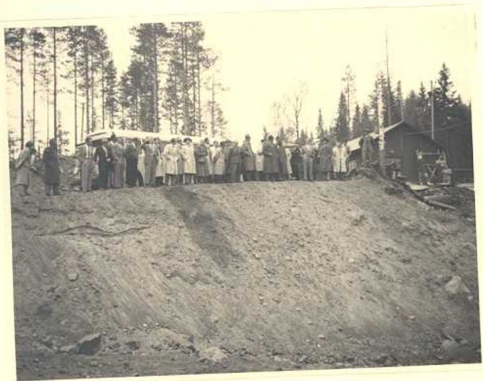
Här bestödas tilloppstunneln vid Storforsen
