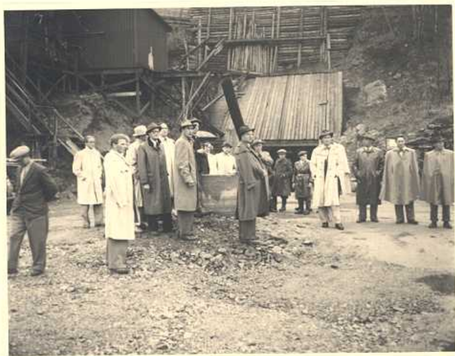
Utlopptunneln Strand förstärkt bestådas.
